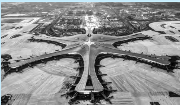
图 1-15 北京大兴国际机场
