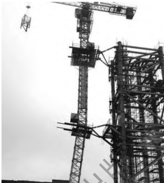
图 3-17 可变角度斜附式塔机
