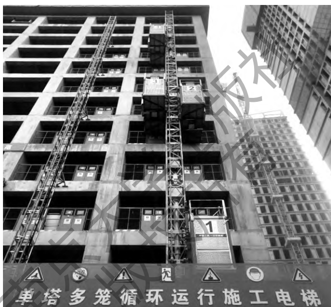
图 3-15 单塔多笼循环运行施工电梯
