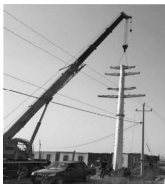
(a) 电线杆吊装现场
