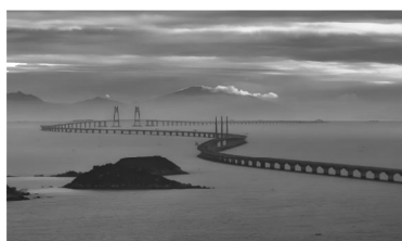
(a) 港珠澳跨海大桥
