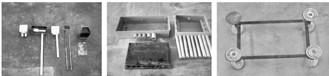
图 2-58 预制墙板内预留预埋所用材料
