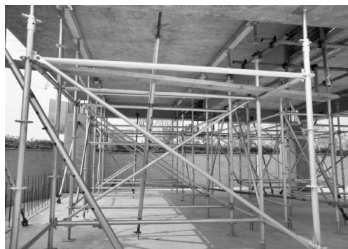
图 1-27 叠合楼板下支撑体系
