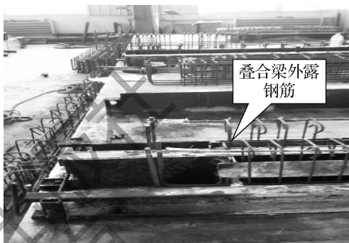
图 2-36 叠合梁钢筋外露长度控制
