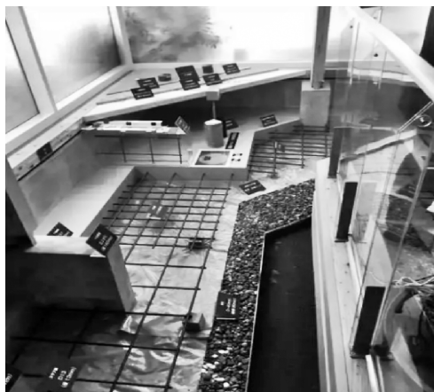
图 0-7 日本装配建筑特色样板房构造剖析
