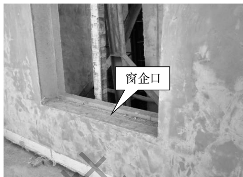
图 2-80 窗洞企口成品示意图
