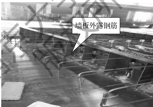
图 2-37 预制墙板外露长度控制
