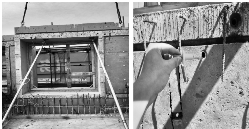
图 1-21 FRP 连接件松脱问题
