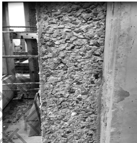
图 2-6 夹心保温墙板端面粗糙处理
