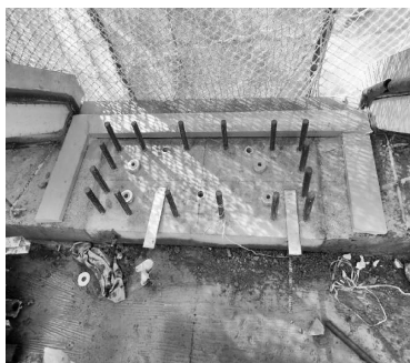
图 1-57 标高抄测及海绵条封堵
