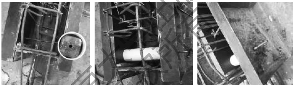
图 2-50 8 mm 通丝固定给水套管于钢模上
