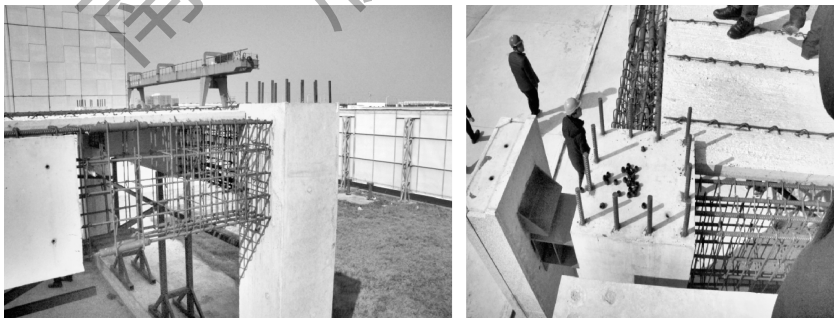
图 1-53 框架柱-梁后浇节点
