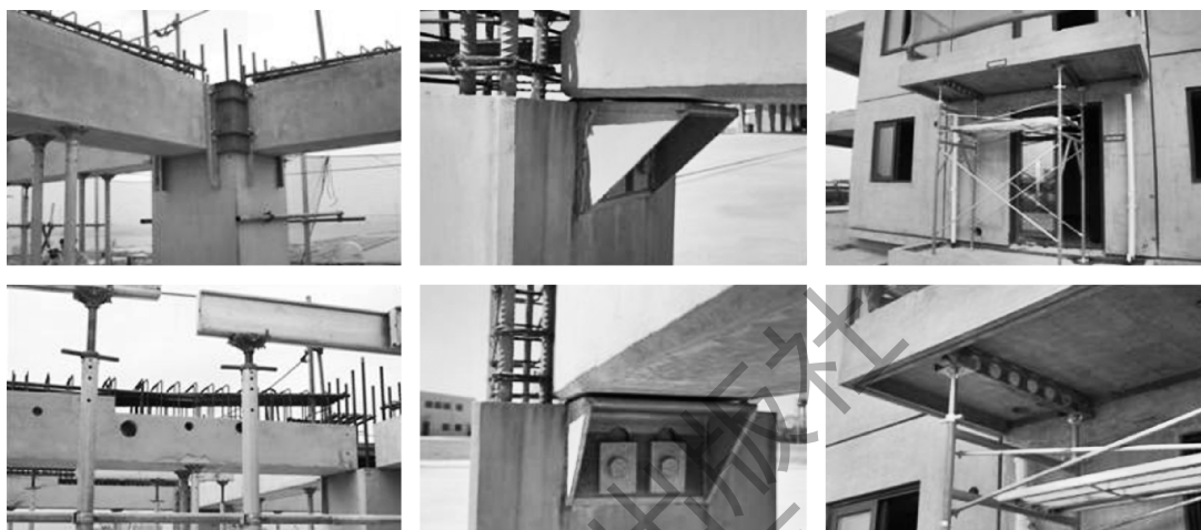
图 1-58 水平向预制构件临时支撑
