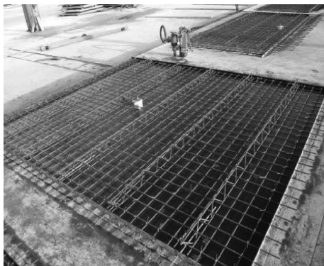
图 2-47 叠合板桁架筋入模情况
