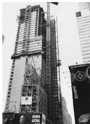
图 0-4 美国钢结构、PC 挂板组合结构
