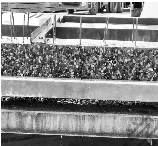
图 2-5 剪力墙板端面粗糙处理
