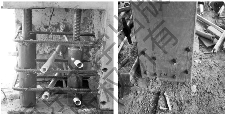
图 1-3 柱纵向钢筋的连接节点(套筒灌浆节点)
