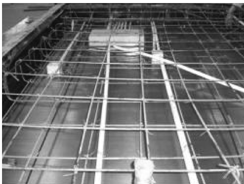
图 2-61 PA-30 强电电箱的安装示意图
