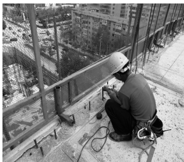
图 1-56 高出部分钢筋现场切除
