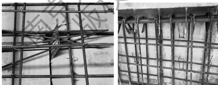
图 1-24 连接件宜被折弯或倾斜
