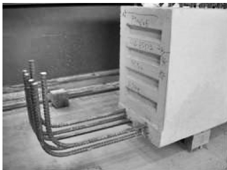
图 1-46 成品预制梁端部键槽
