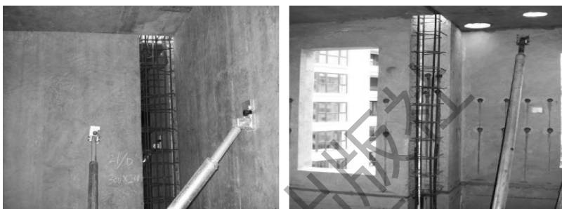
剪力墙“T”型连接节点
