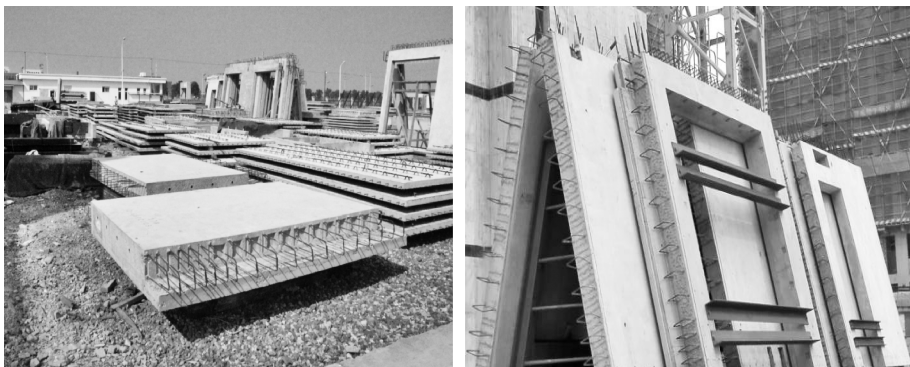
图 1-14 夹心保温板墙(三明治板)
