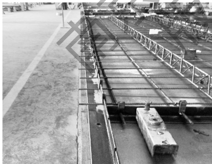
图 2-42 叠合板外伸钢筋加工成型
