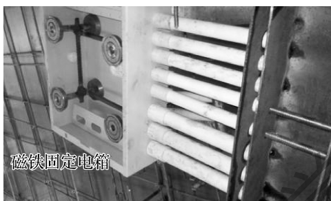
图 2-63 电箱安装示意图
