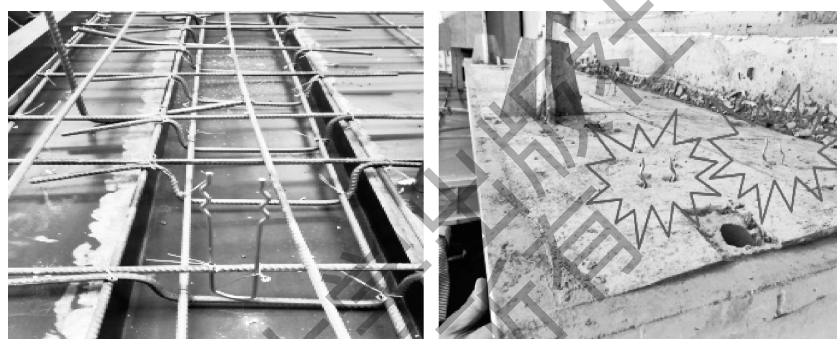
图 1-23 别针连接件无限位易下沉
