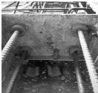
图 2-91 台模外侧边防漏浆橡皮塞
