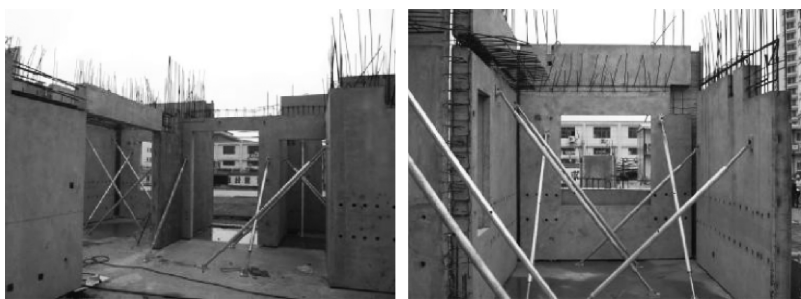
图 0-23 浆锚搭接连接现场吊装
