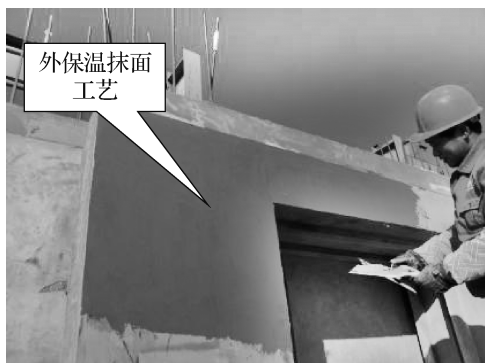
图 2-28 外墙保温抹面施工
