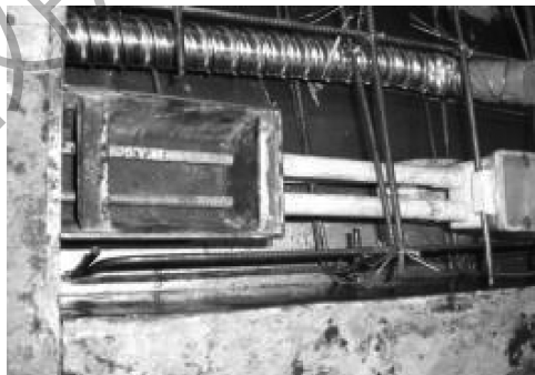
图 2-60 下部线盒安装示意图
