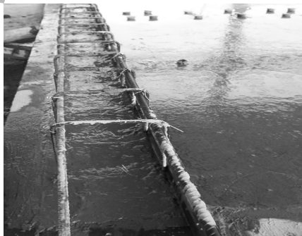
图 2-43 叠合梁板钢筋混凝土浇筑成型
