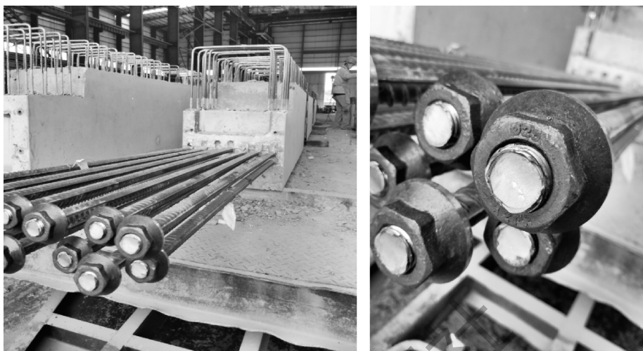
图 1-38 现场叠合梁纵向钢筋锚固板
