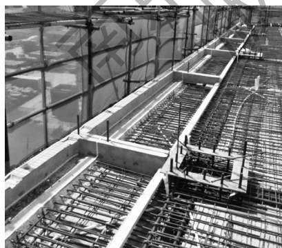
图 1-43 叠合阳台现场构件拼装
