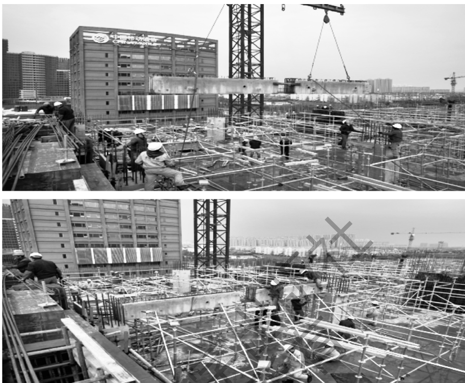
图 1-33 叠合梁现场吊装
