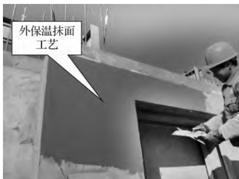
图 2-28 外墙保温抹面施工
