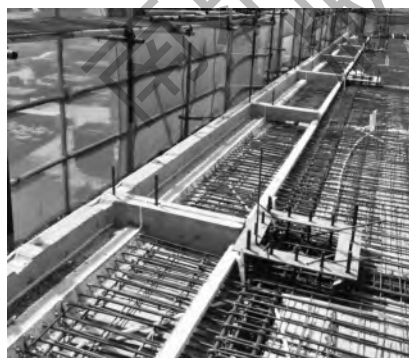
图 1-43 叠合阳台现场构件拼装
