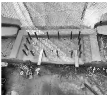
图 1-57 标高抄测及海绵条封堵
