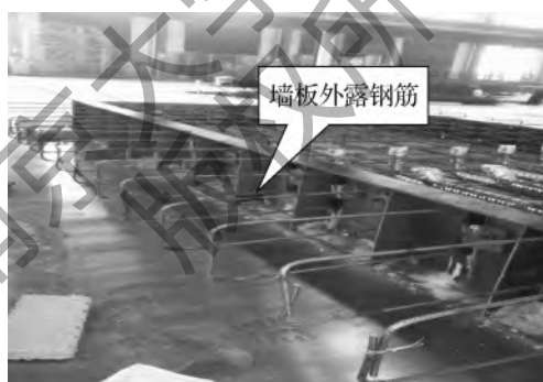
图 2-37 预制墙板外露长度控制
