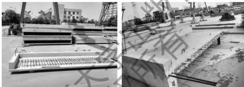
图 1-42 叠合阳台构件图
