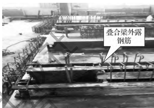
图 2-36 叠合梁钢筋外露长度控制
