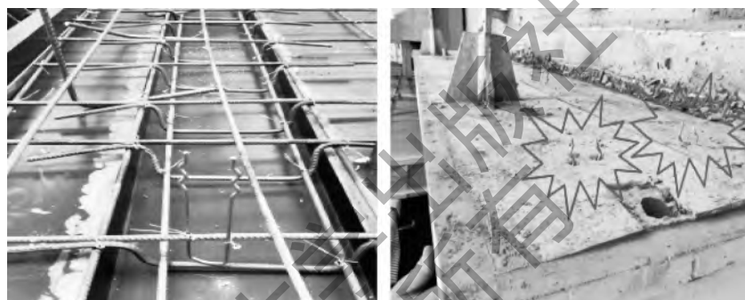
图 1-23 别针连接件无限位易下沉
