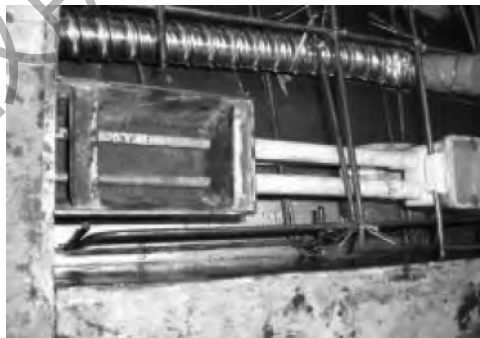
图 2-60 下部线盒安装示意图
