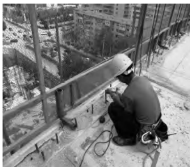
图 1-56 高出部分钢筋现场切除
