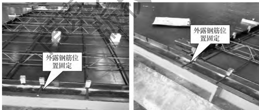
图 2-34 外露钢筋位置固定
