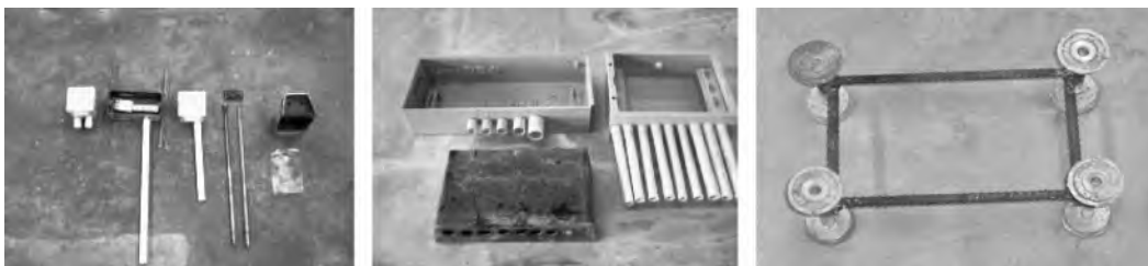
图 2-58 预制墙板内预留预埋所用材料
