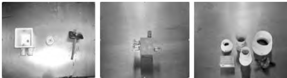
图 2-53 PVC 线盒、固定磁铁及固定件、铁盒、地漏、防水套管、固定件及水泥预块留洞
