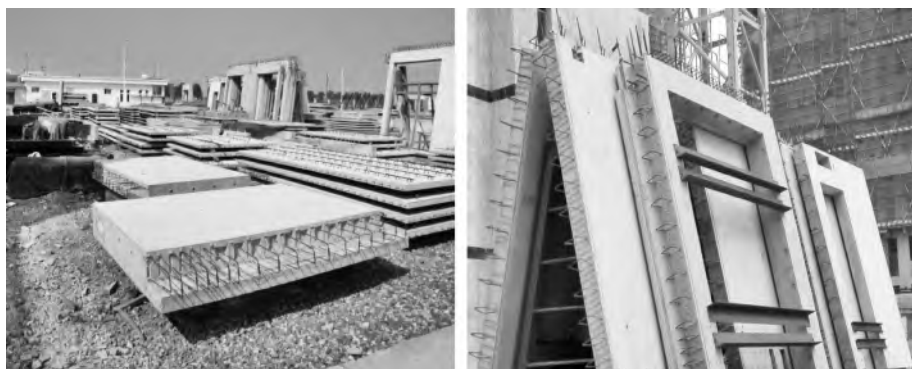
图 1-14 夹心保温板墙(三明治板)
