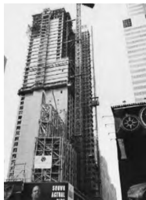
图 0-4 美国钢结构、PC 挂板组合结构
