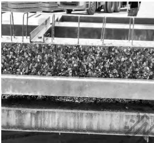
图2-5 剪力墙板端面粗糙处理
