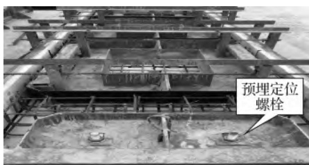
图 2-26 浇筑前挂板支模图
