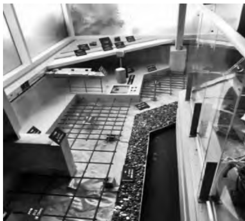
图 0-7 日本装配建筑特色样板房构造剖析
