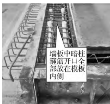
图 2-38 剪力墙暗柱箍筋外伸及箍筋开口位置
