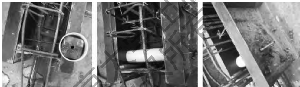
图 2-50 8 mm 通丝固定给水套管于钢模上
