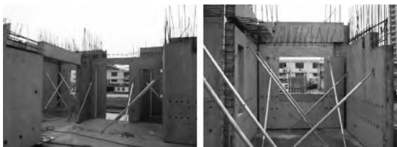
图 0-23 浆锚搭接连接现场吊装
