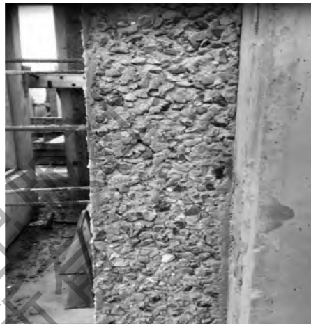
图2-6 夹心保温墙板端面粗糙处理
