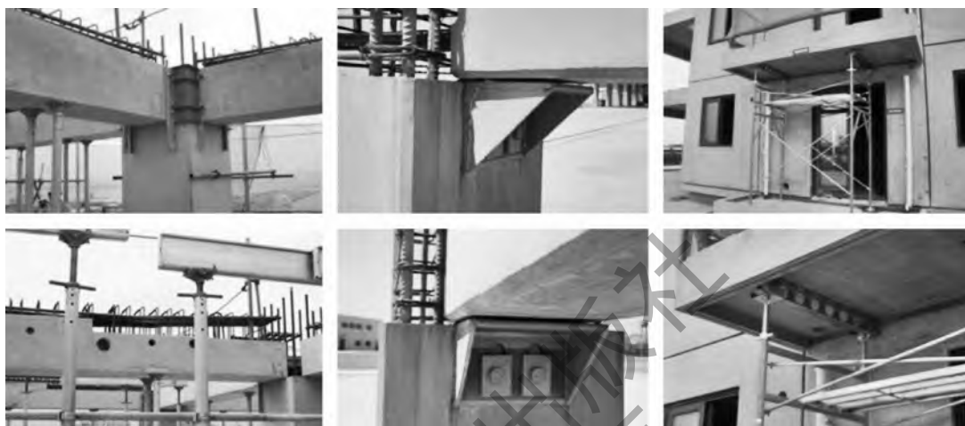
图 1-58 水平向预制构件临时支撑
