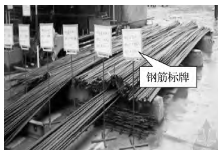
图 2-46 钢筋分类堆放
