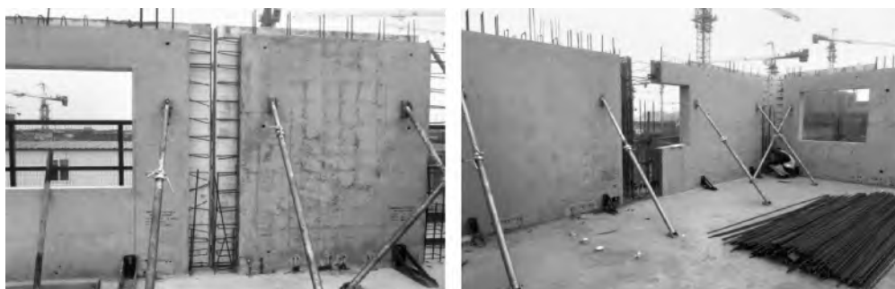
图 1-60 夹心保温外墙封模
