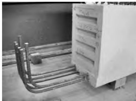
图 1-46 成品预制梁端部键槽
