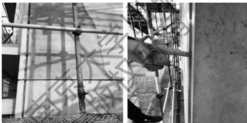
图 1-20 转角带保温悬翼 PC 板加强问题
