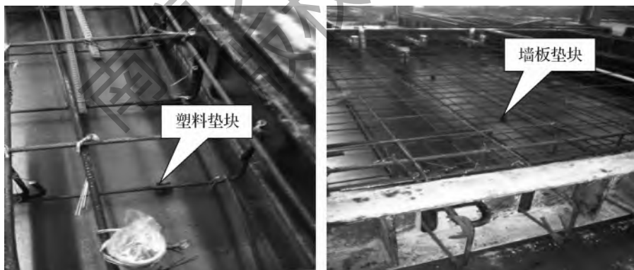
图 2-33 钢筋垫块放置
