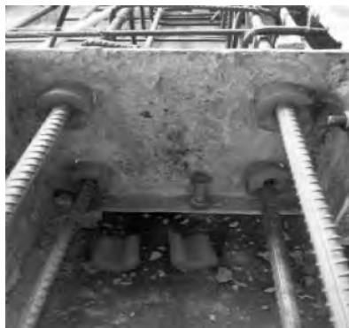
图 2-91 台模外侧边防漏浆橡皮塞
