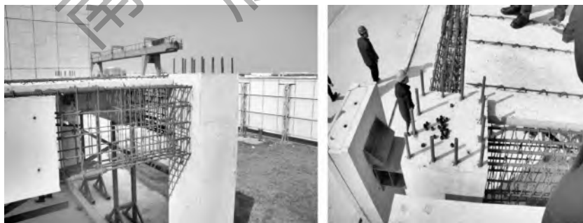
图 1-53 框架柱-梁后浇节点
