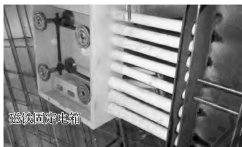
图 2-63 电箱安装示意图
