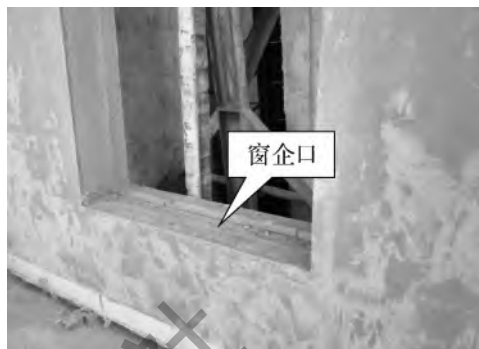
图 2-80 窗洞企口成品示意图
