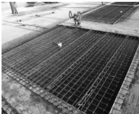
图 2-47 叠合板桁架筋入模情况
