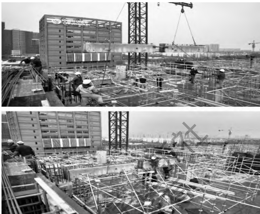
图 1-33 叠合梁现场吊装
