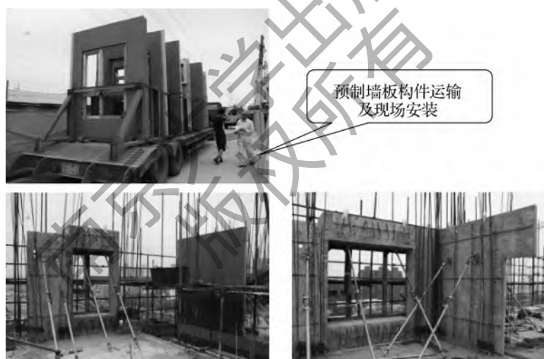
图 0-19 预制墙板构件运输及现场安装
