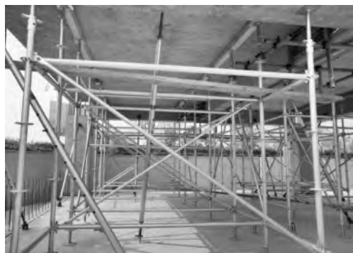
图 1-27 叠合楼下支撑体系
