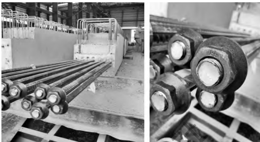
图 1-38 现场叠合梁纵向钢筋锚固板
