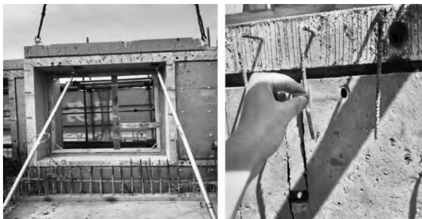
图 1-21 FRP 连接件松脱问题
