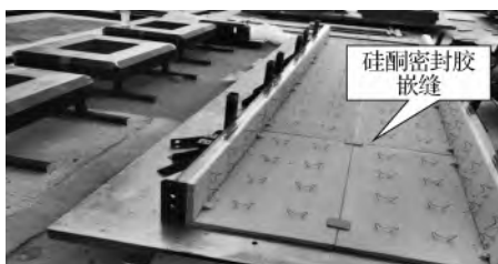
图 2-25 完成的石材铺设图
