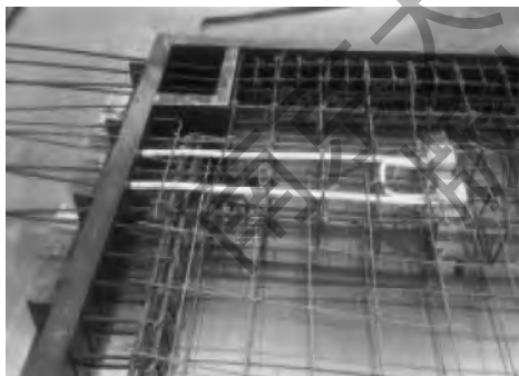
图 2-59 上部线盒安装示意图
