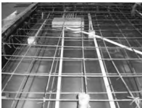
图 2-61 PA-30 强电电箱的安装示意图
