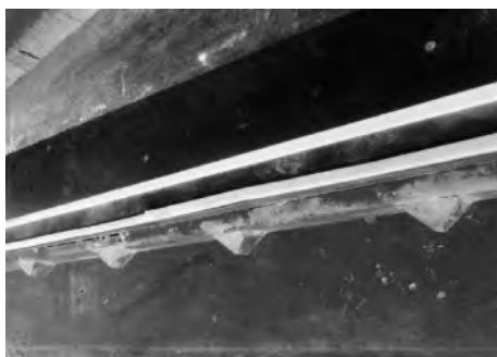
图 2-89 海绵条防漏浆
