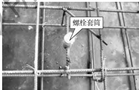
图 2-70 螺栓套筒
