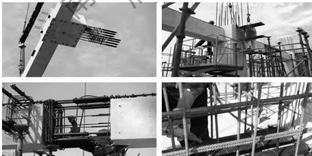
图 1-55 水平构件钢筋灌浆套筒连接(叠合梁)
