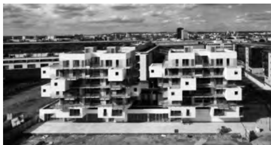
图 0-2 法国巴黎 28 套公寓楼 (法国世构体系建筑)
