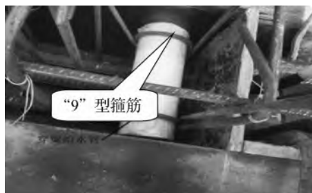
图 2-49 “9”型箍筋固定给水套管
