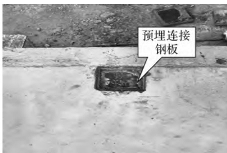
图 2-75 预埋连接钢板
